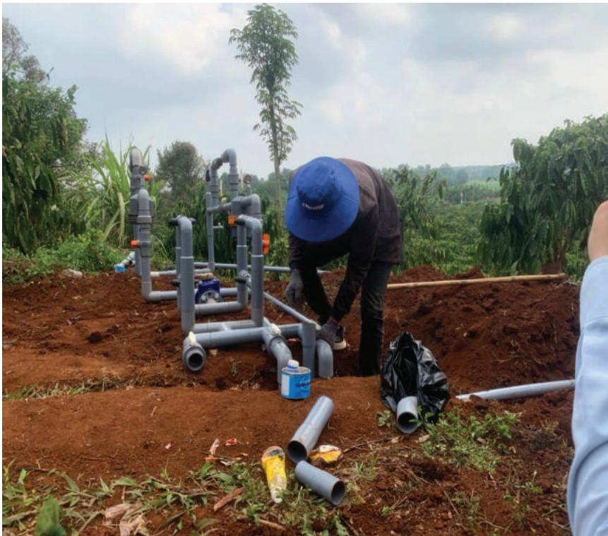
► Cán bộ kỹ thuật của Trung tâm lắp đặt hệ thống tưới tại mô hình.
