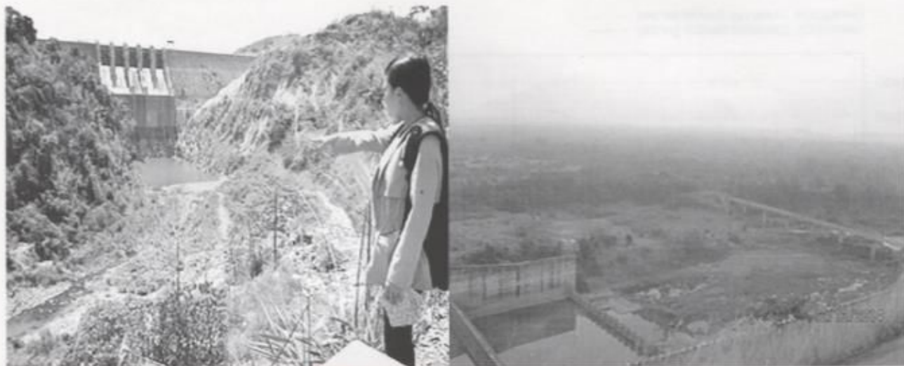
Hình 3: Đoạn phía sau đập thủy điện Đồng Nai 4 và Buôn Kuốp khô cạn nước
