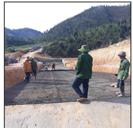
► Thi công mô hình tràn sự cố hồ Đắk Noh
