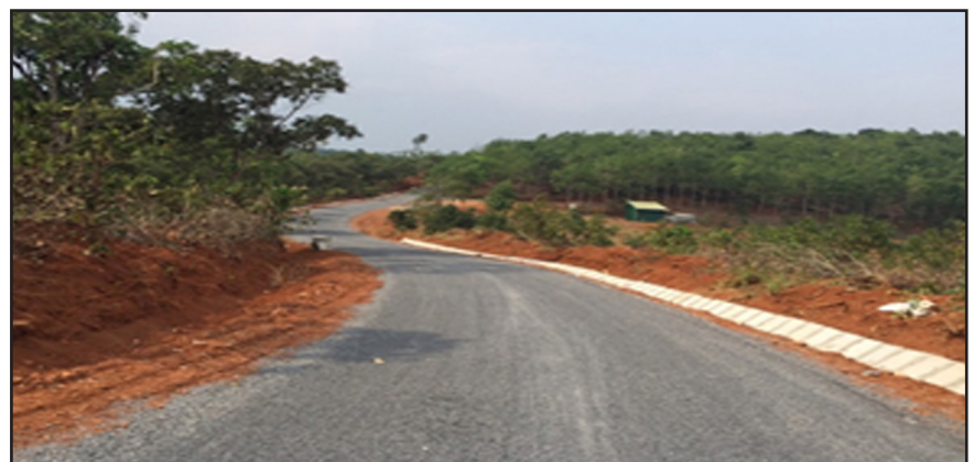
► Hoàn thiện mô hình 2km đường
